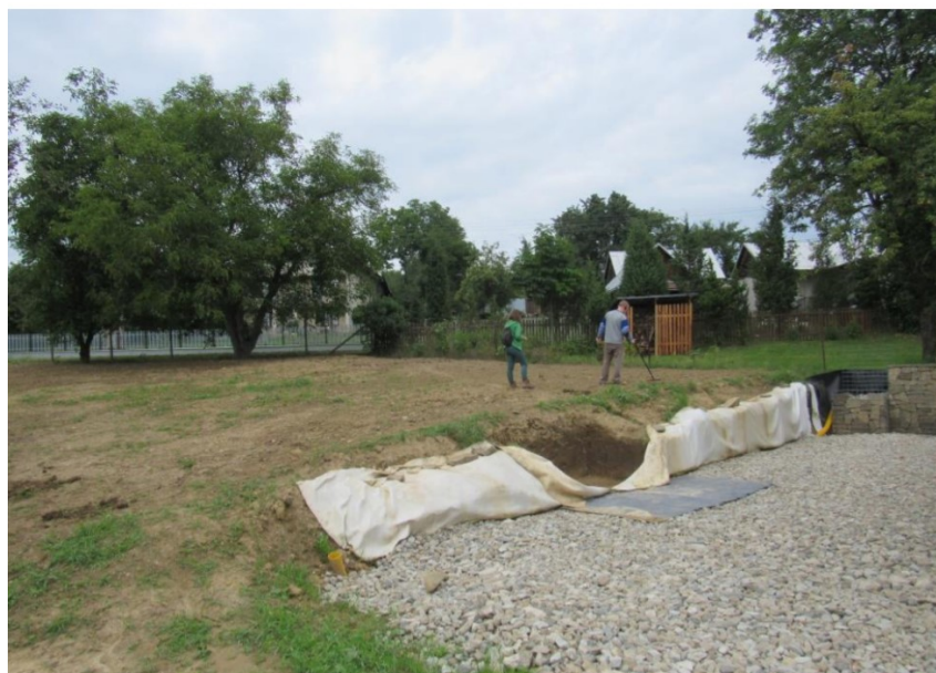
Pohľad na plochu dvora
